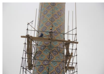
(نصب داربست اطراف گلدسته)
